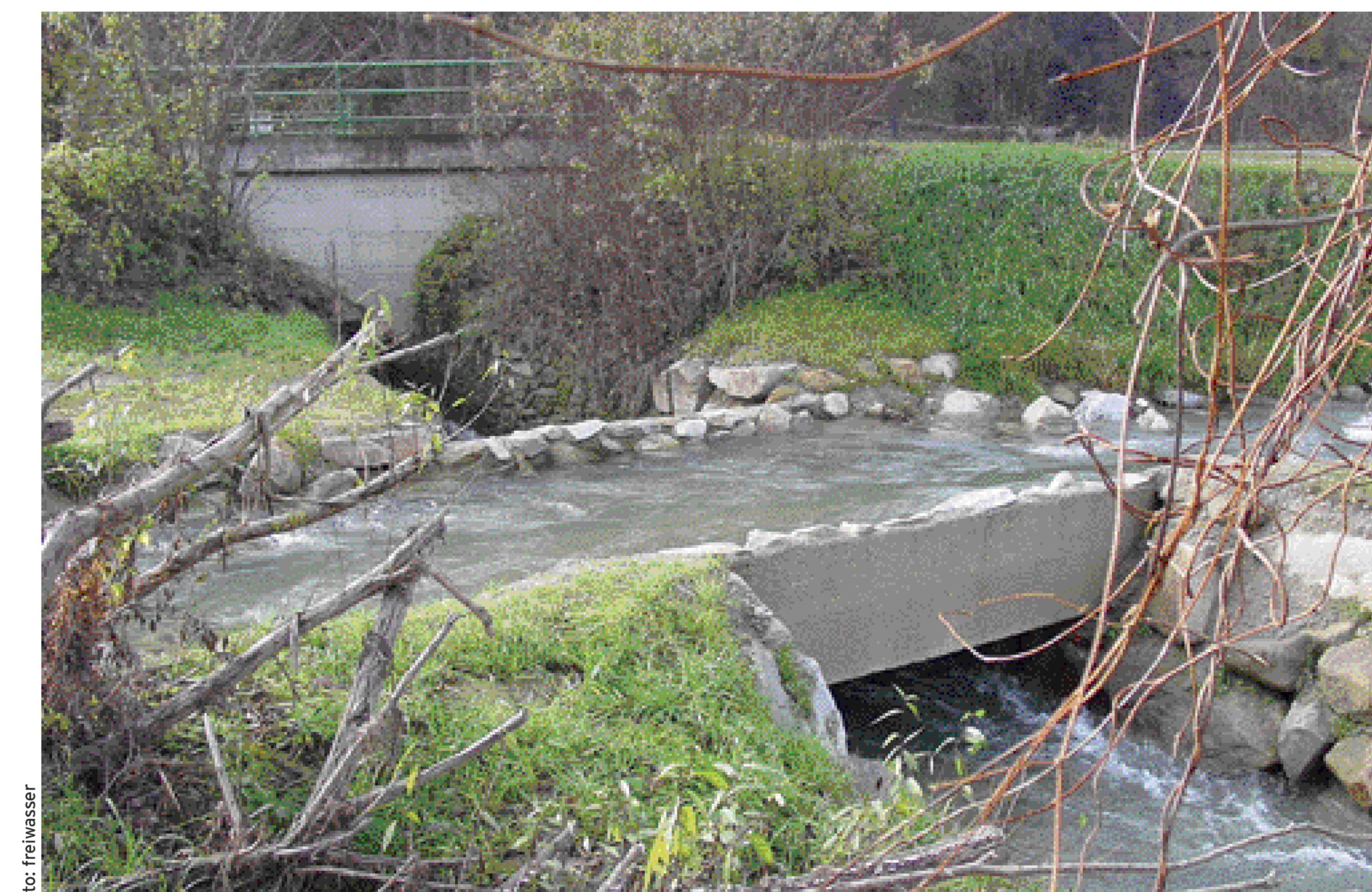
Auch Speziallösungen waren nötig. Der Umgehungsbach fließt über den Spülkanal des Mühlbaches. Der Bach über dem Bach war eine Herausforderung für die Experten.
