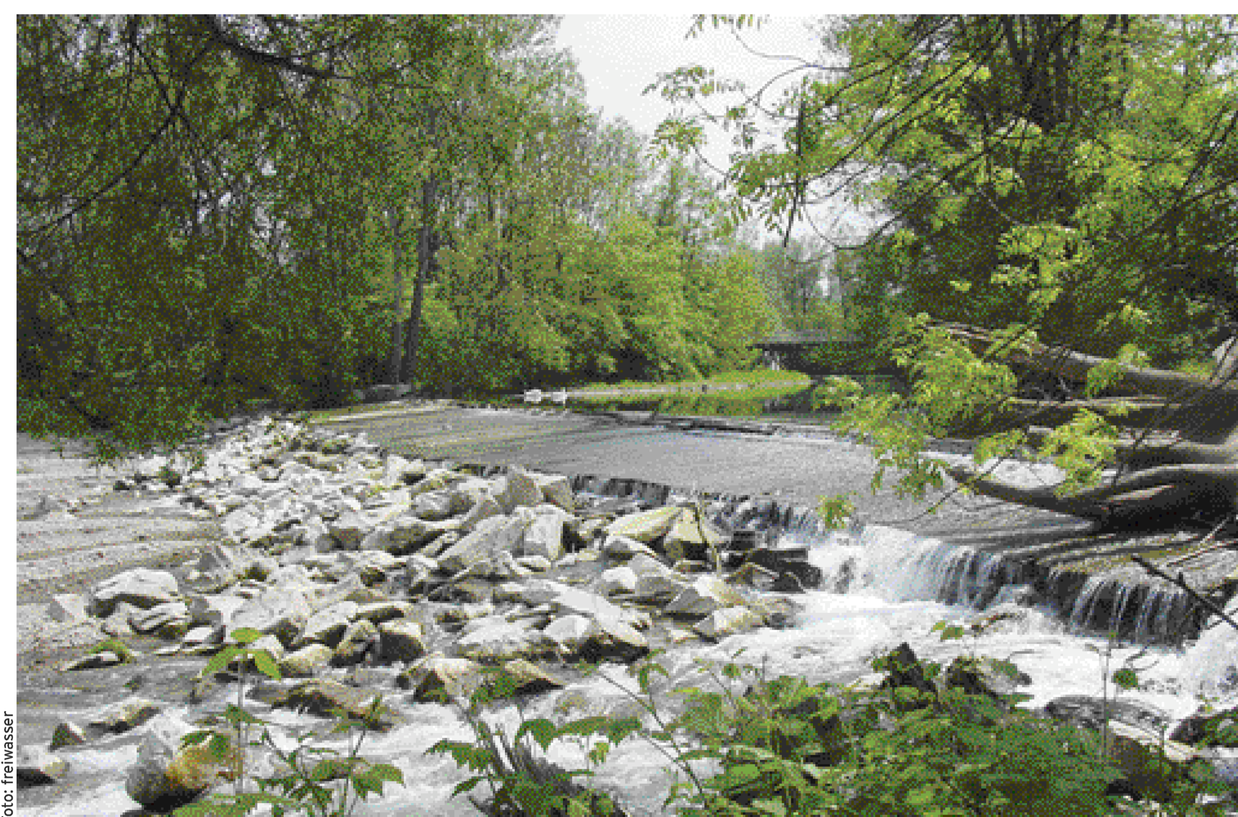
Die Spielberger Wehranlage zu Beginn des LIFE Projektes war ein Hindernis für die Fischwanderung. Der vorgelagerte Blockwurf dient zur Abstützung des alten Steinkastenwehres.
