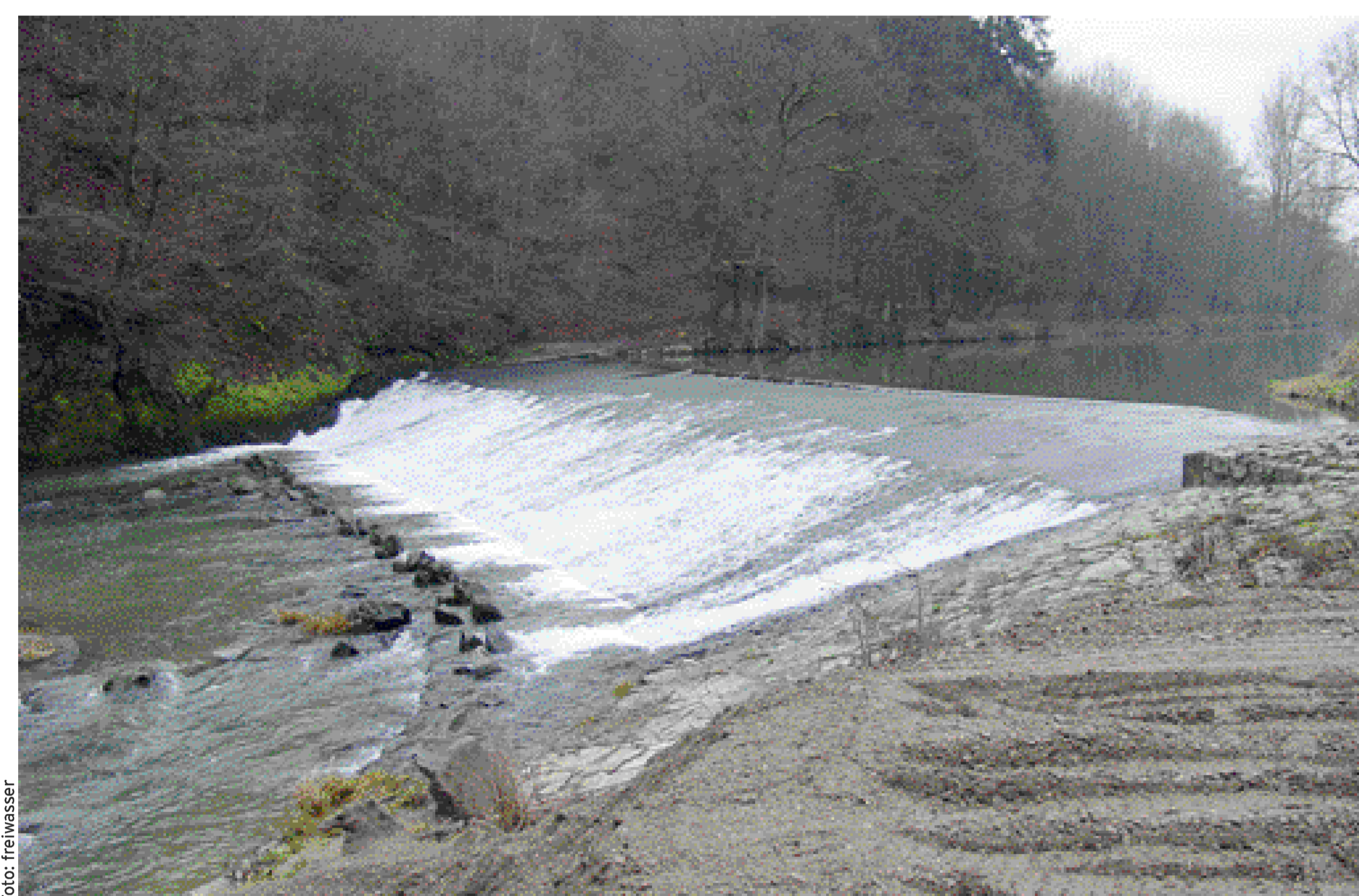
Die Wehranlage Bauer zu Beginn des LIFE Projektes. Die glatte und steile Rampe des Wehrkörpers verhinderte die flussaufgerichtete Fischwanderung im Melkfluss ganzjährig.
