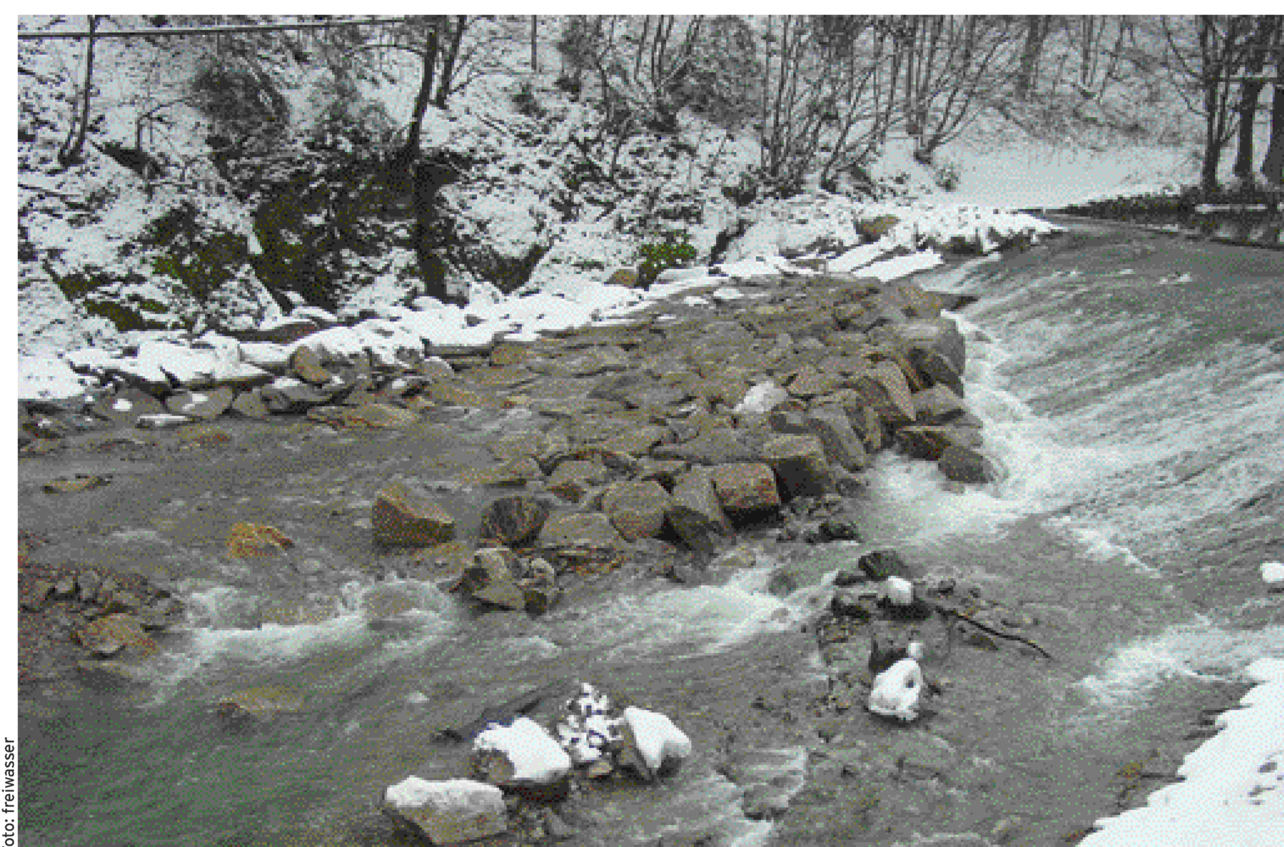
Baubeginn im strengen Winter 2002. Die Blocksteine für den Unterbau der Fischwanderhilfe sind schon zu sehen. Die Kälte erzwang eine Unterbrechung der Bauarbeiten, die aber keine negativen Auswirkungen auf das Projekt hatte.
