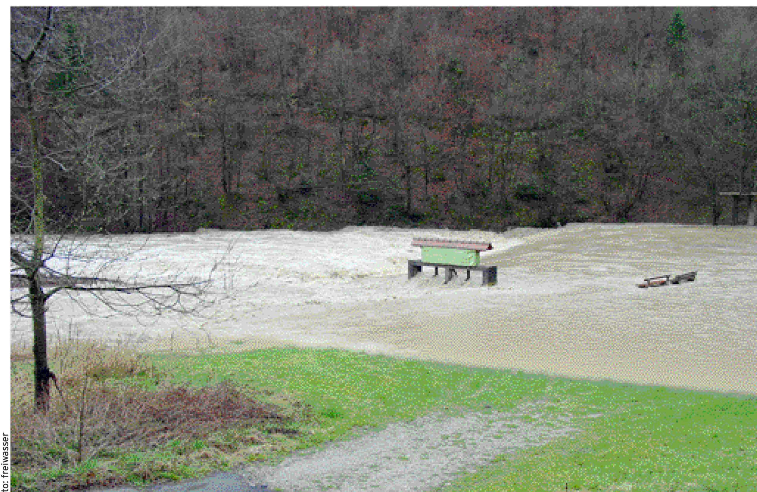
Die massive Bauweise ist nötig. Die Fischwanderhilfe steht zur Gänze im direkten Hochwasserabfluss. Das Bild zeigt die Wehranlage im verheerenden Hochwasserjahr 2002.
