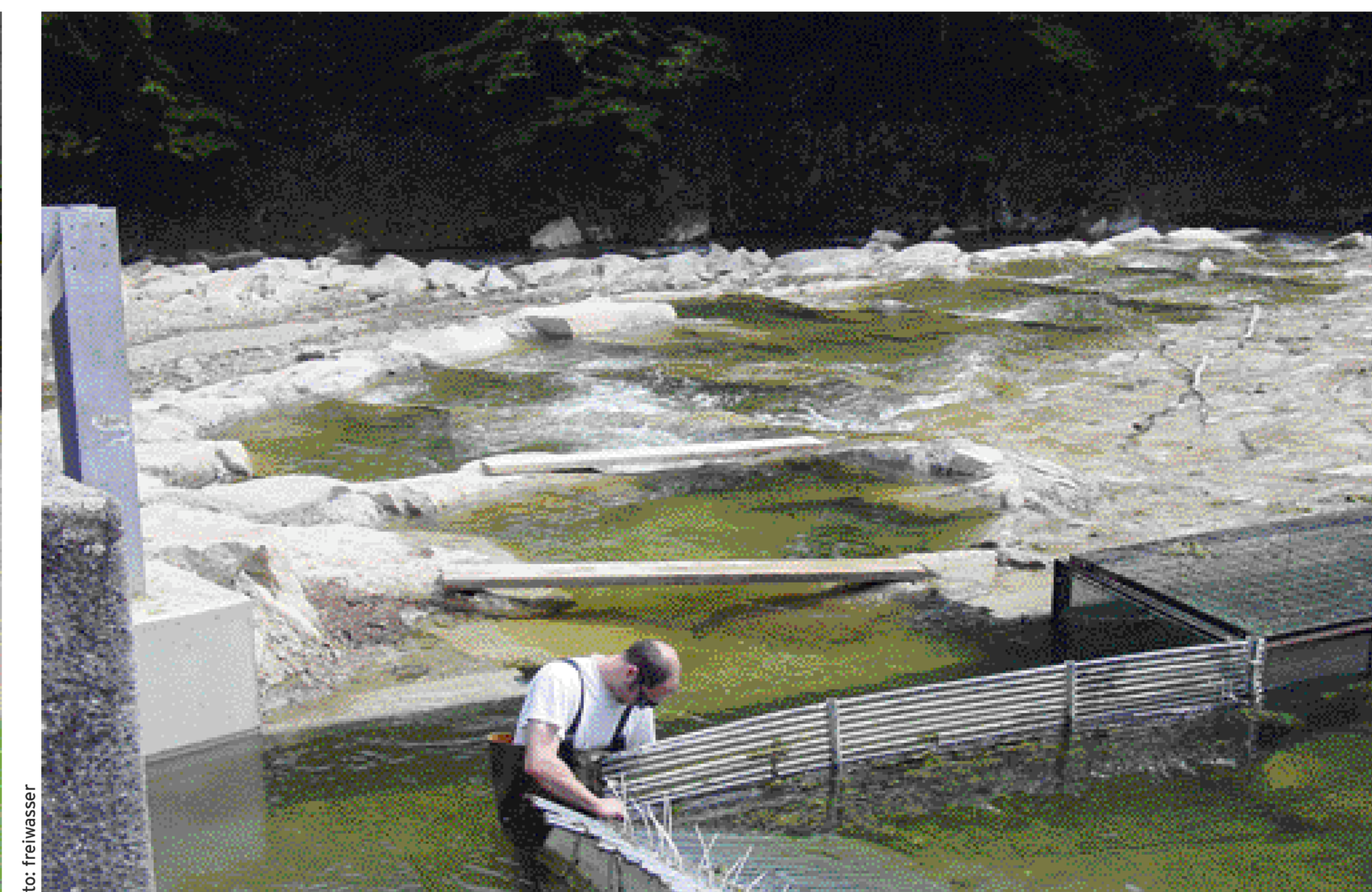
Erster Teil der Fischwanderhilfe, quer über die Wehranlage. Im Vordergrund wird die Fischreue montiert. Sogar Donaufische erreichten die 9 km von der Melkmündung entfernte Wehranlage.
