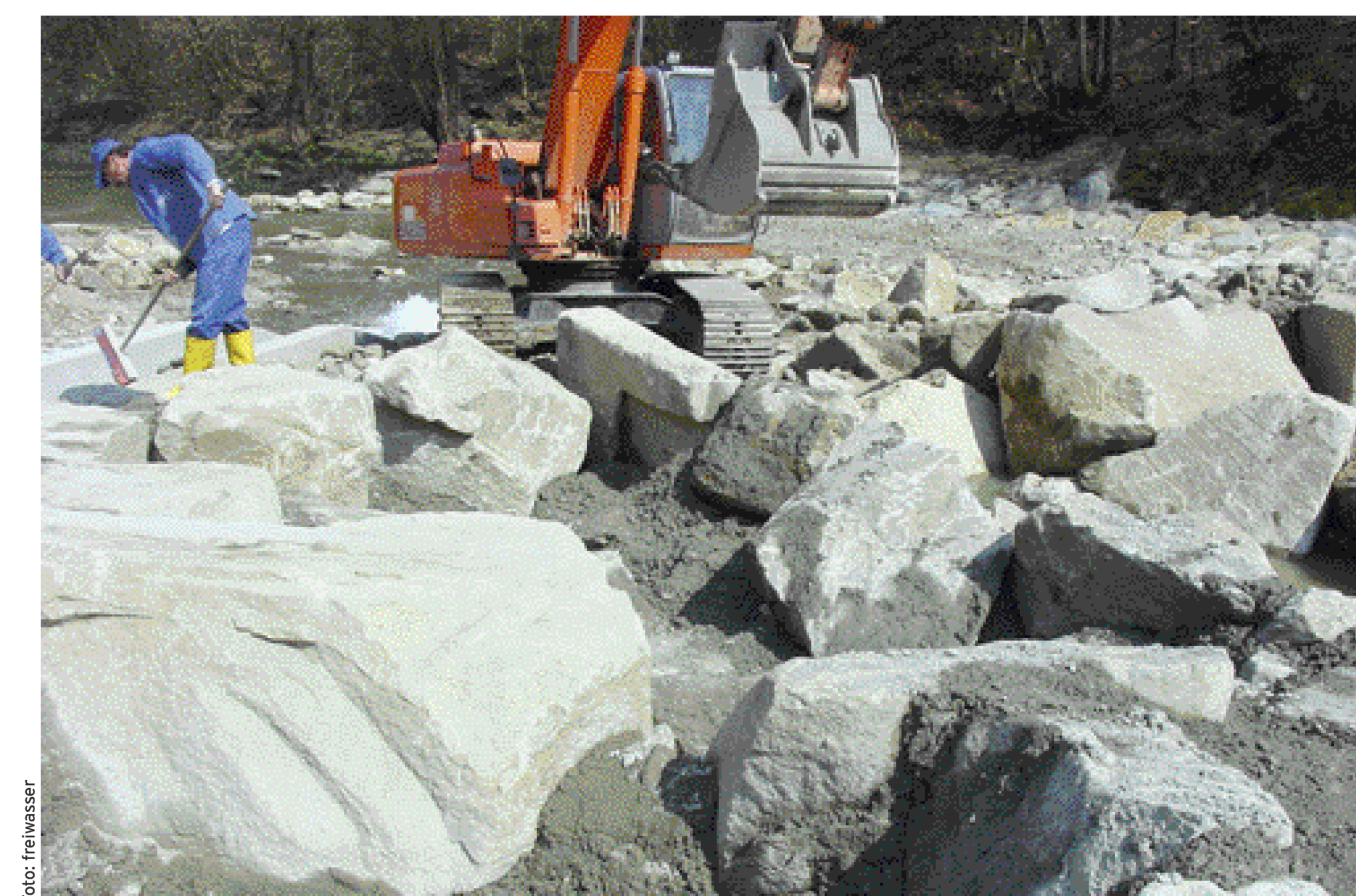
Die Baustelle fürs Grobe. Die Blocksteine werden in Beton verlegt, dazwischen sind die Becken der Fischwanderhilfe zu erkennen.
