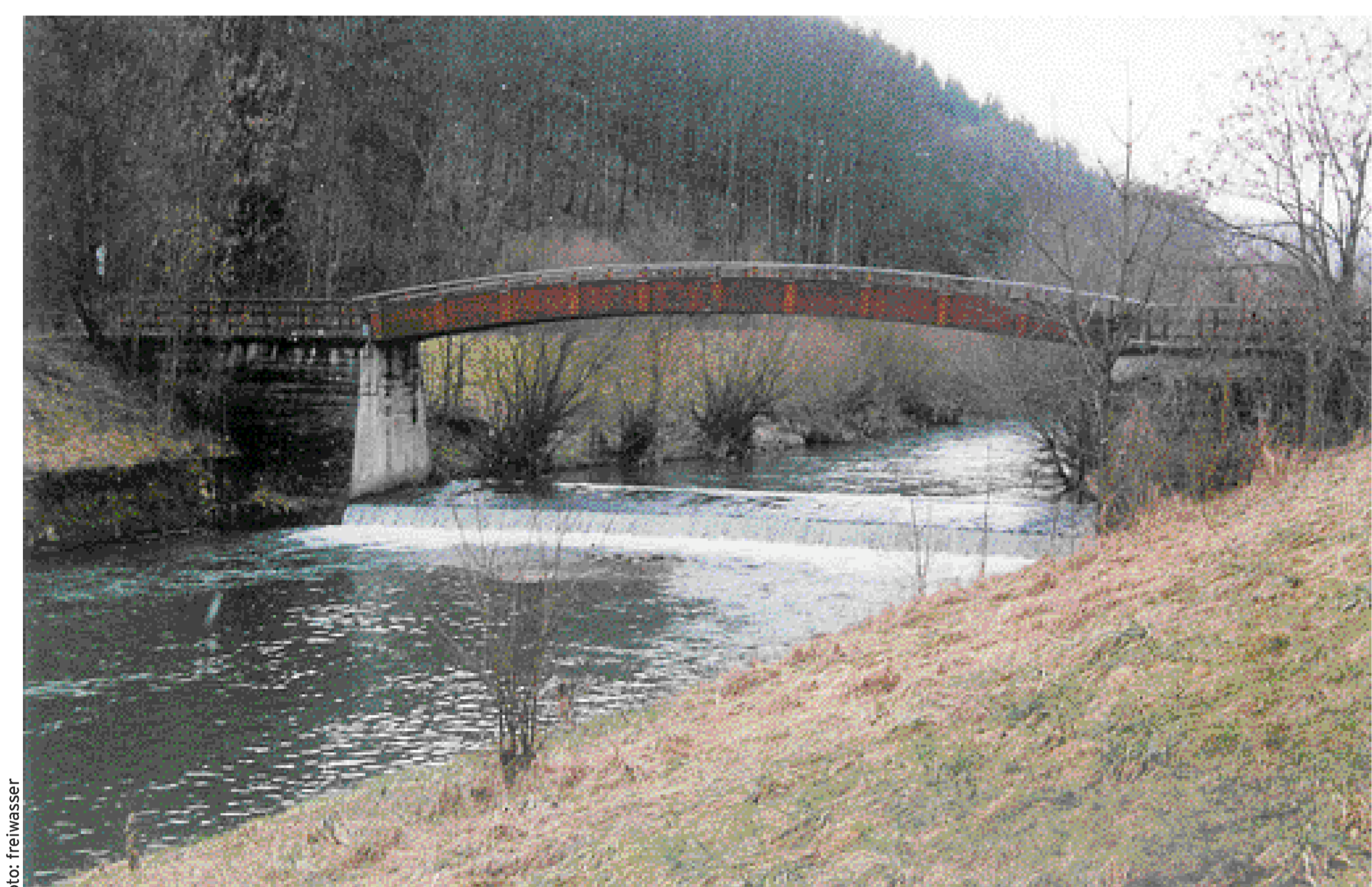
Die Sohlrampe Weißer Stein mit Brücke zu Beginn des LIFE Projektes. Der ein Meter hohe, senkrechte Absturz verhinderte die flussaufgerichtete Wanderung im Melkfluss.
