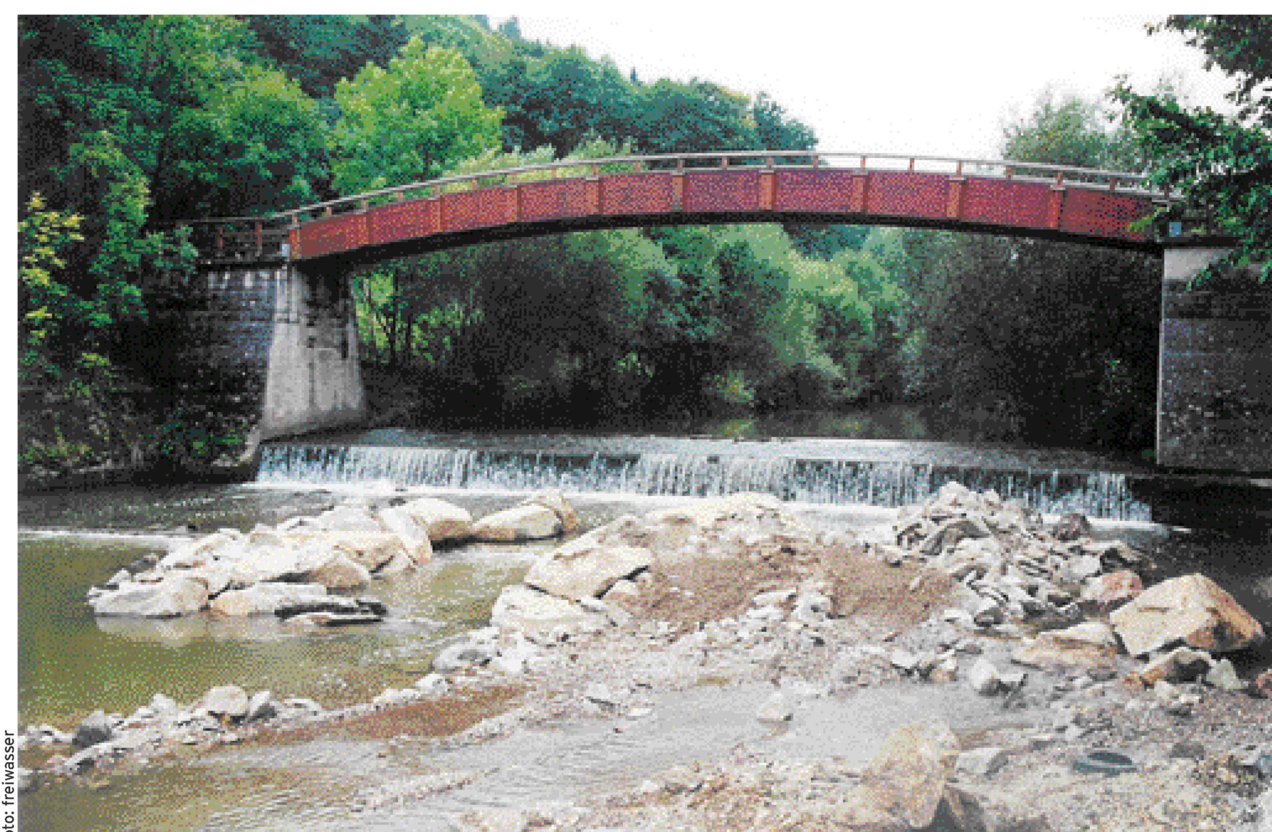
Die Sohlstufe zu Beginn der Bauarbeiten. Blocksteine für die Rampe und das raue Gerinne werden in das Flussbett gelegt. Noch wurde die Schwelle nicht eingekerbt.
