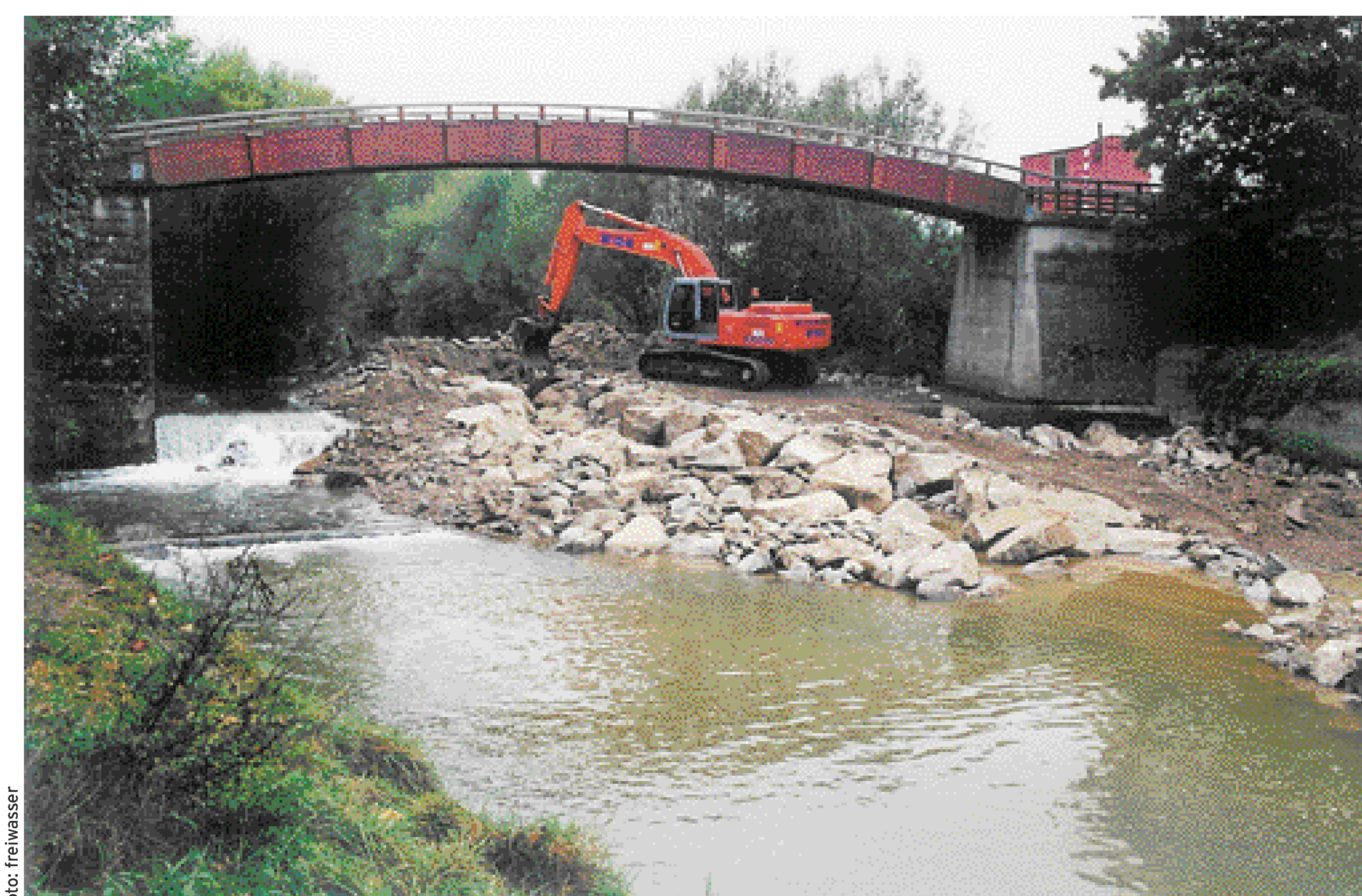
Die Rampe und das raue Gerinne sind bereits aufgebaut, die Rampe in der Mitte eingekerbt. Der Melkfluss fließt seitlich vorbei. Die Baustraße ist noch zu sehen.
